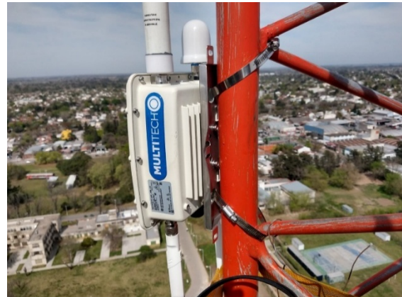
Fig. 1. Foto del gateway instalado aproximadamente a 80 m de altura. Se observan las antenas de LoRa, GPS y LTE.
